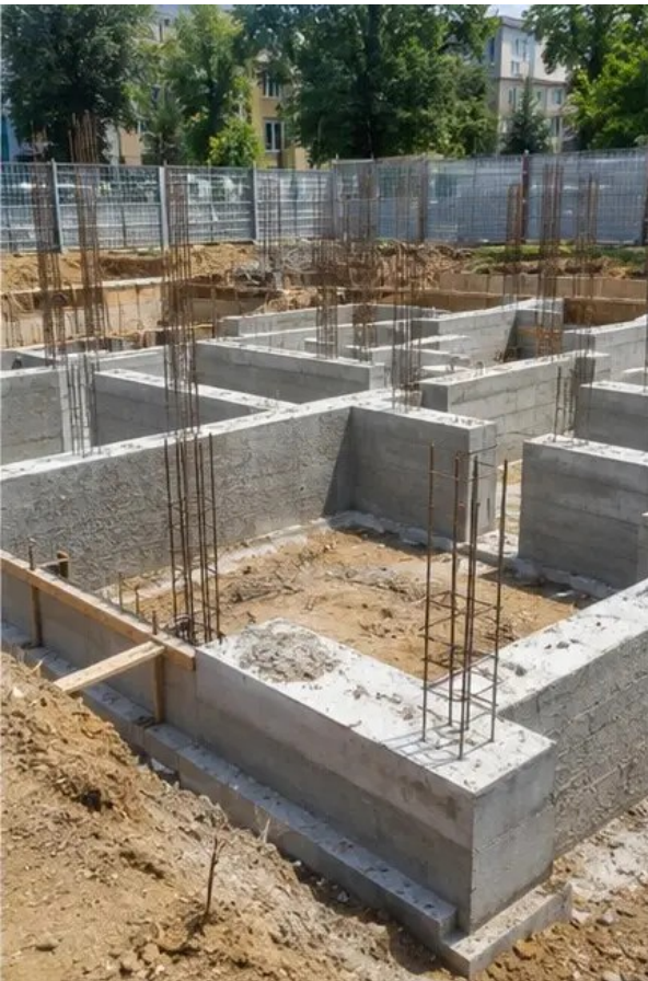
Foto nr.3 Fundamentkonstruktion i gang
