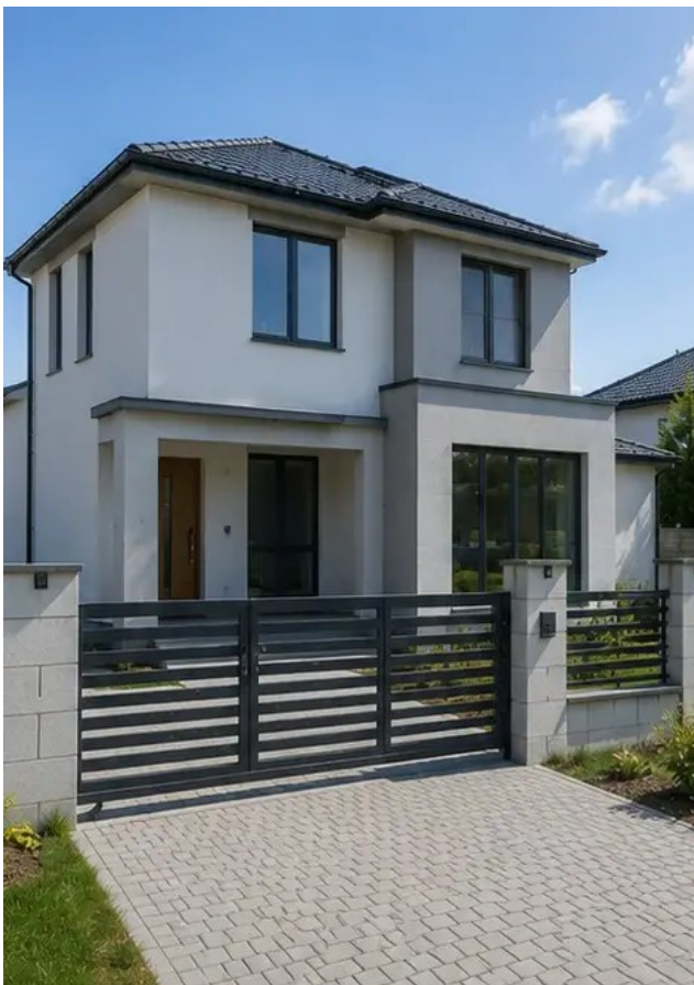
Foto nr.15 Færdig bygningseksteriør efter byggeri
