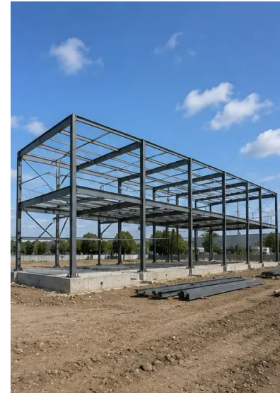
Foto nr.7. Opførelse af bærende konstruktion i gang
