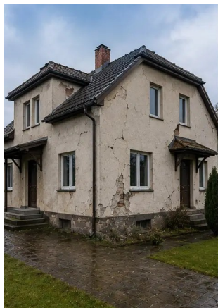
Photo #1. Celkový pohled na kontrolovanou nemovitost
