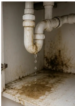
Photo #11. Poškození únikem vody z instalace zdokumentováno
