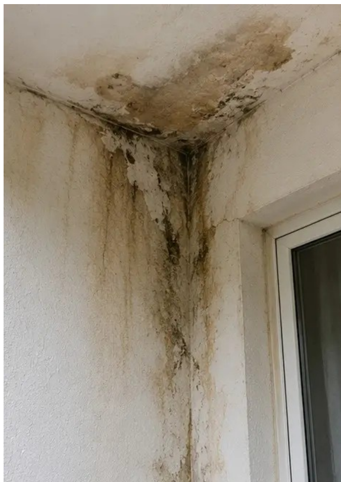
Fotografie č. 6 Oblast poškození vodou identifikována a zaznamenána
