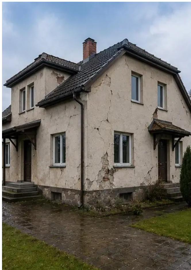
Fotografie č. 1 Celkový pohled na kontrolovanou nemovitost
