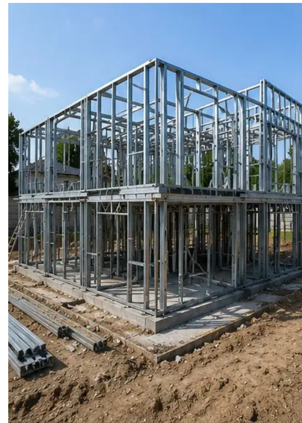
Fotografie č. 6 Probíhá montáž konstrukčního skeletu
