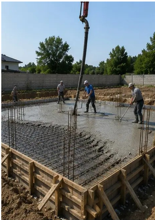
Fotografie č. 5 Prováděna betonáž základových prvků
