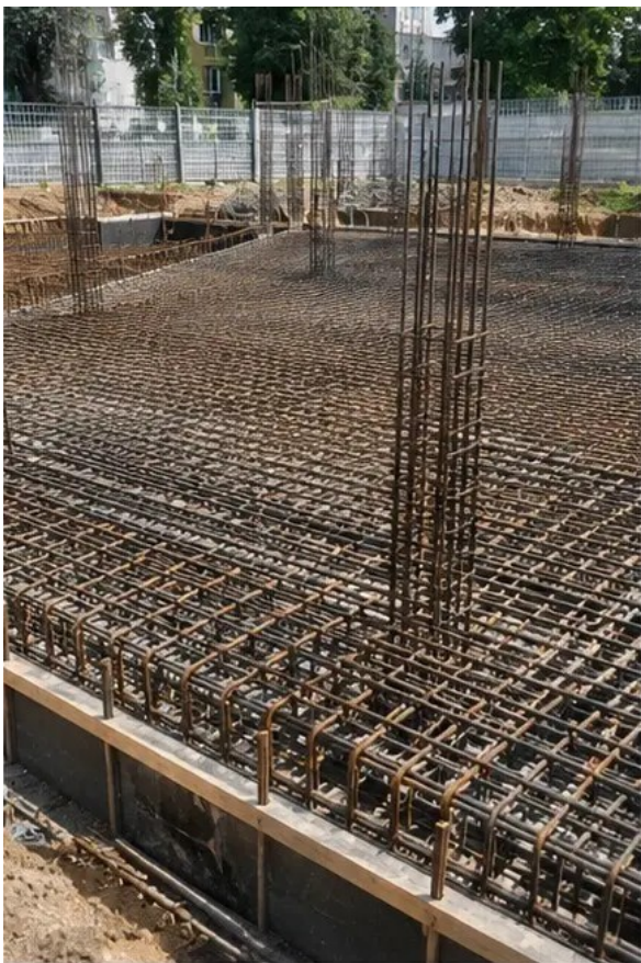
Fotografie č. 4 Instalace výztuže dokončena před betonáží
