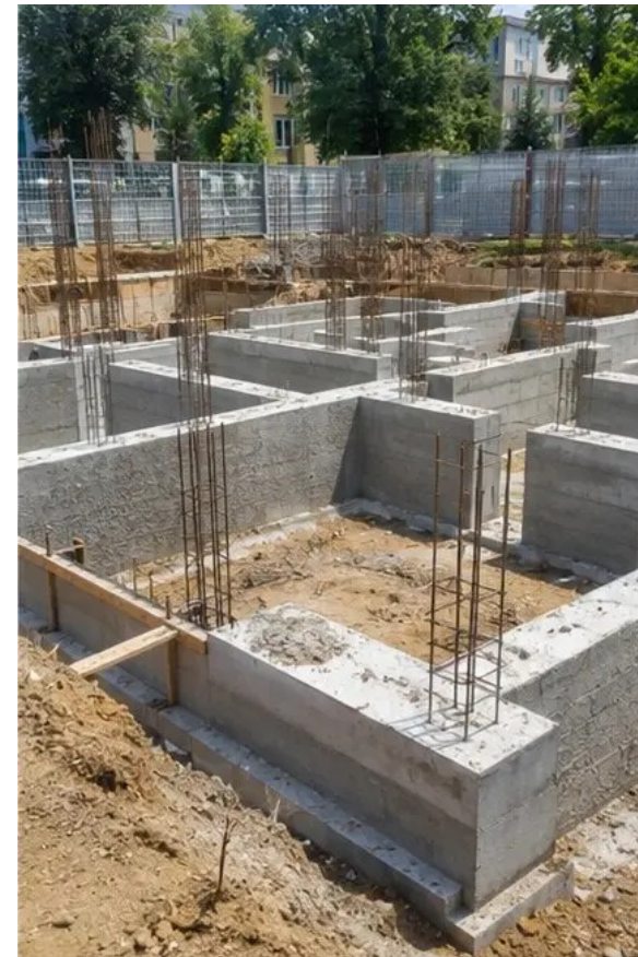
Fotografie č. 3 Probíhá výstavba základů
