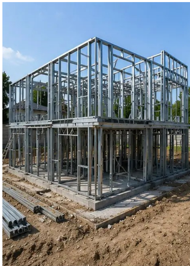
Fotografie č. 6 Probíhá montáž konstrukčního skeletu
