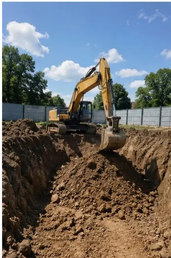
Fotografie č. 2 Výkopové práce provedeny dle požadavků projektu
