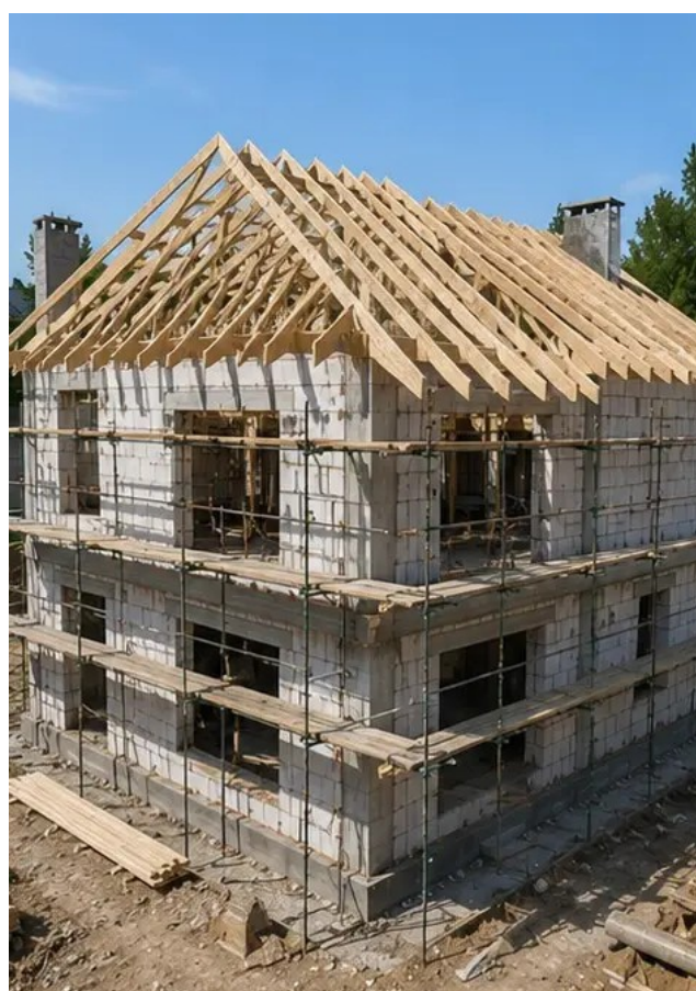
Fotografie č. 8 Montáž střechy dokončena
