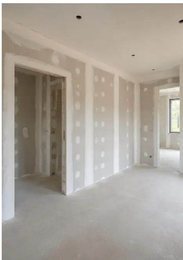
Fotografie č. 11 Probíhají dokončovací práce na vnitřních stěnách
