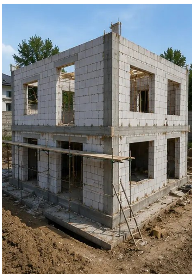
Fotografie č. 7 Výstavba obvodových stěn dokončena pro část budovy
