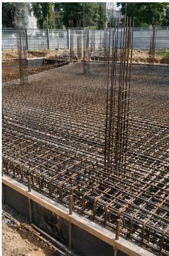
Fotografie č. 4 Instalace výztuže dokončena před betonáží
