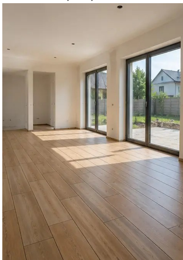
Fotografie č. 12 Pokládka podlah dokončena dle specifikací projektu
