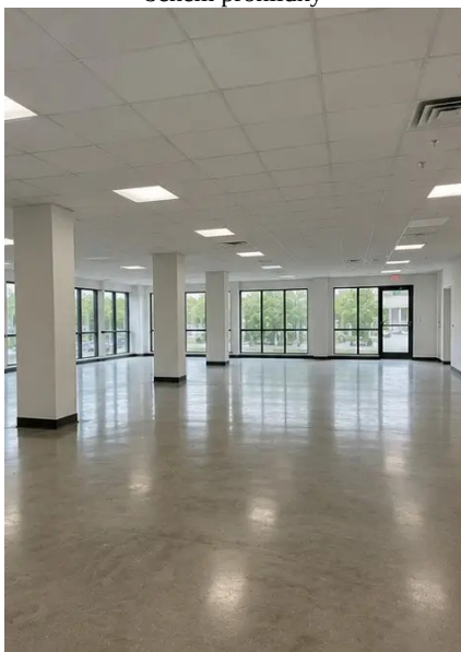
Photo #16. Závěrečný přehled kontrolované nemovitosti
