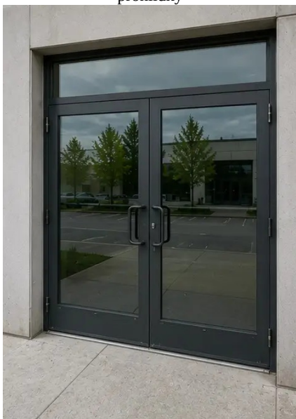
Photo #7. Stav dveří zkontrolován a zaznamenán
