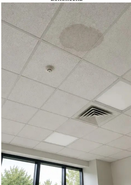
Photo #13. Stav stropu zdokumentován během prohlídky
