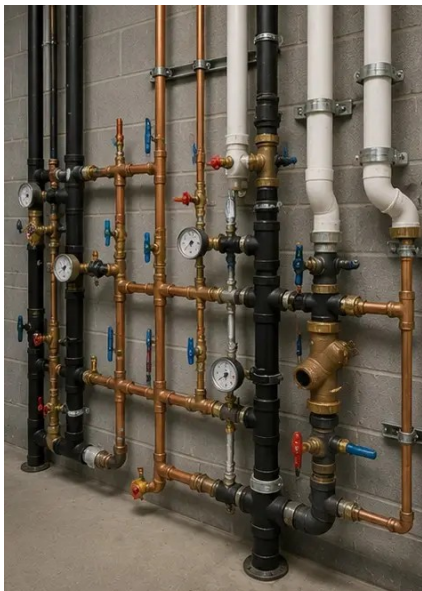
Photo #10. Kontrola instalátérského systému dokončena
