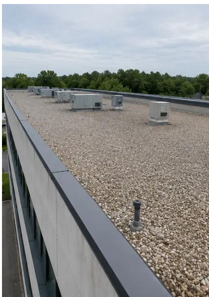
Photo #5. Kontrola stavu střechy dokončena
