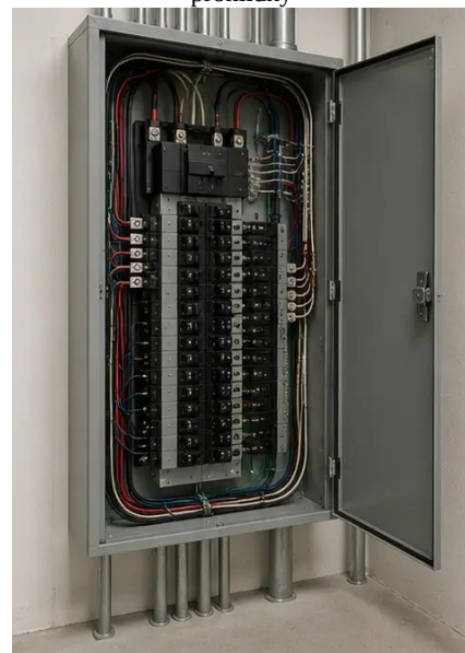
Photo #9. Stav elektrického rozvaděče zdokumentován
