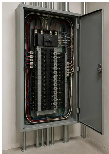
Photo #9. Stav elektrického rozvaděče zdokumentován
