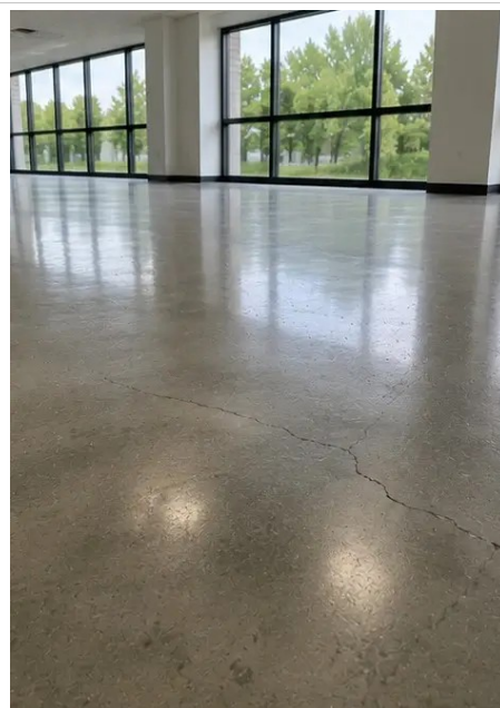
Photo #14. Stav podlahy posouzen a zaznamenán
