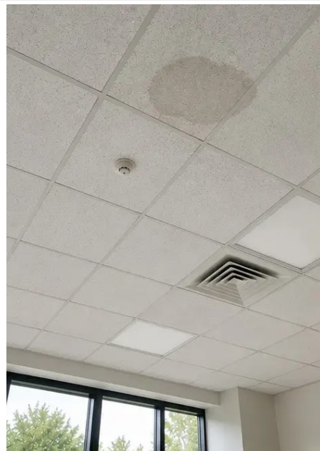
Photo #13. Stav stropu zdokumentován během prohlídky
