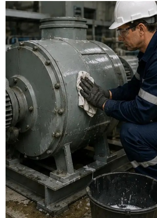
Fotografie č. 12. Procedura čištění zařízení dokončena
