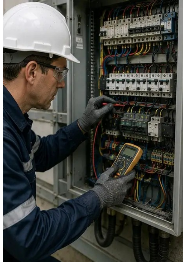
Fotografie č. 5. Provedena kontrola elektrického rozvaděče
