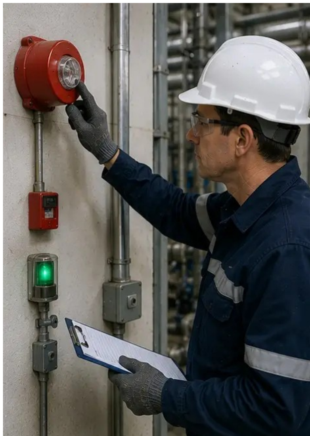
Fotografie č. 13. Kontrola bezpečnostního systému dokončena
