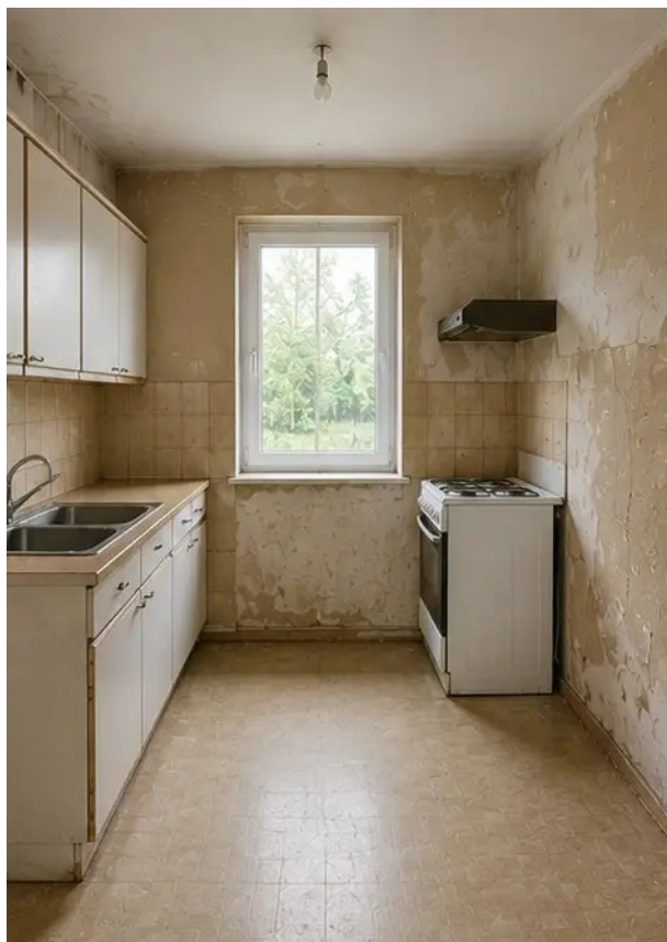
Fotografie č. 11 Stav kuchyně před rekonstrukcí
