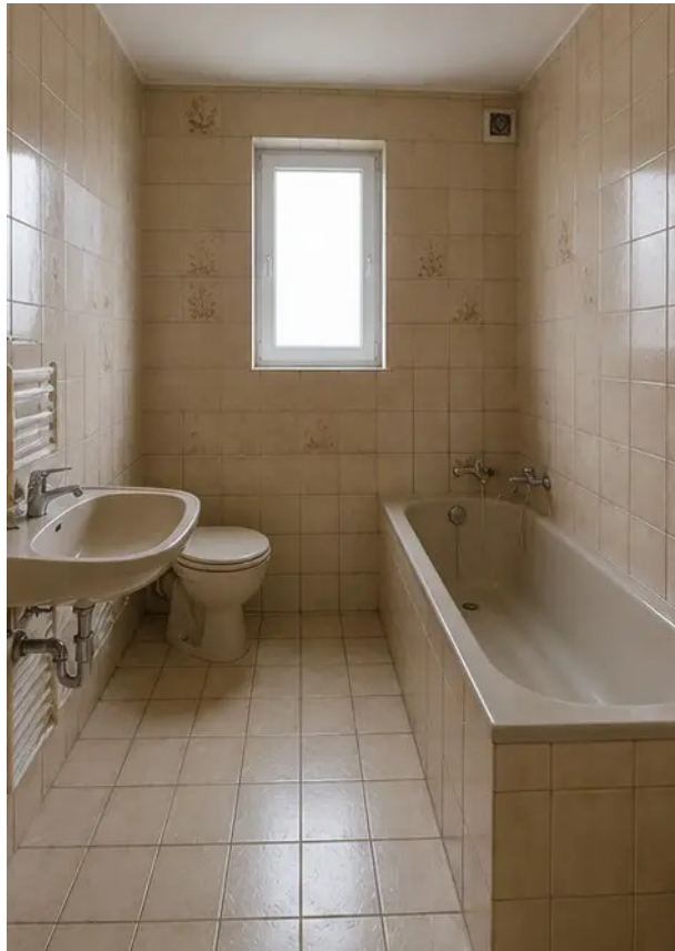
Fotografie č. 9 Stav koupelny před rekonstrukcí
