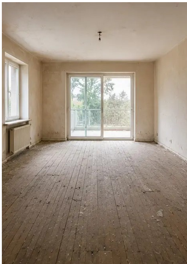
Fotografie č. 1 Stav obývacího pokoje před rekonstrukcí
