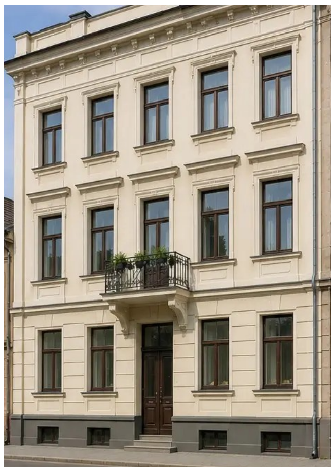
Fotografie č. 14 Fasáda budovy po restaurátorských pracích
