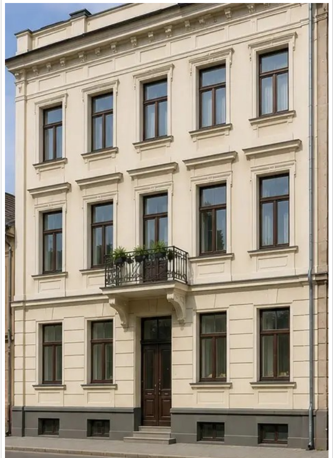
Fotografie č. 14 Fasáda budovy po restaurátorských pracích
