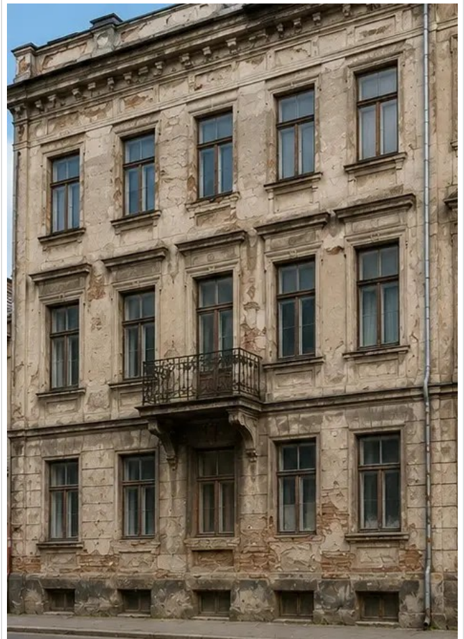
Fotografie č. 13 Fasáda budovy před restaurátorskými pracemi
