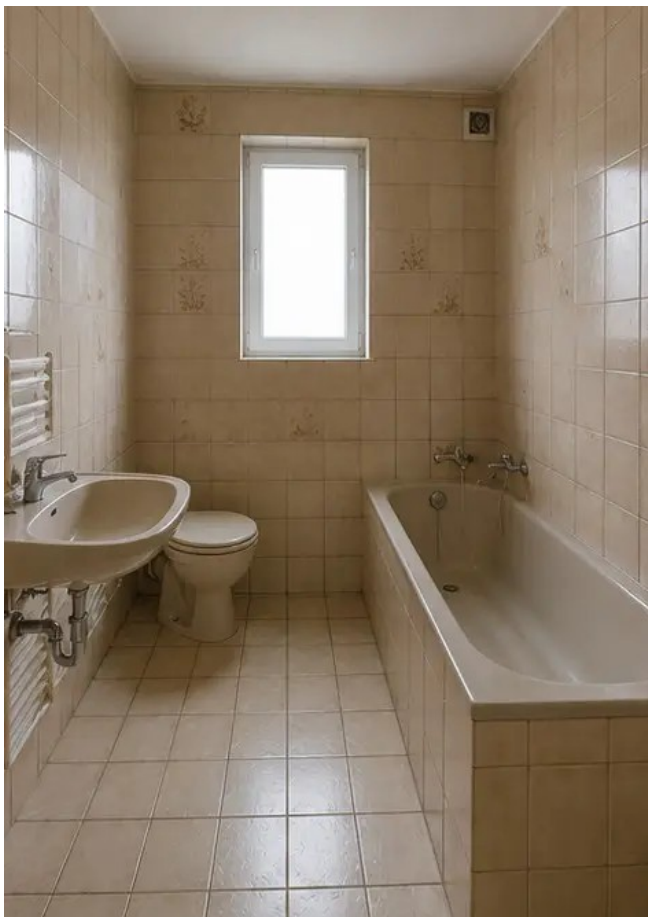
Fotografie č. 9 Stav koupelny před rekonstrukcí
