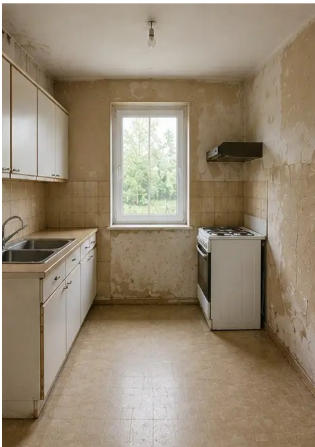
Fotografie č. 11 Stav kuchyně před rekonstrukcí
