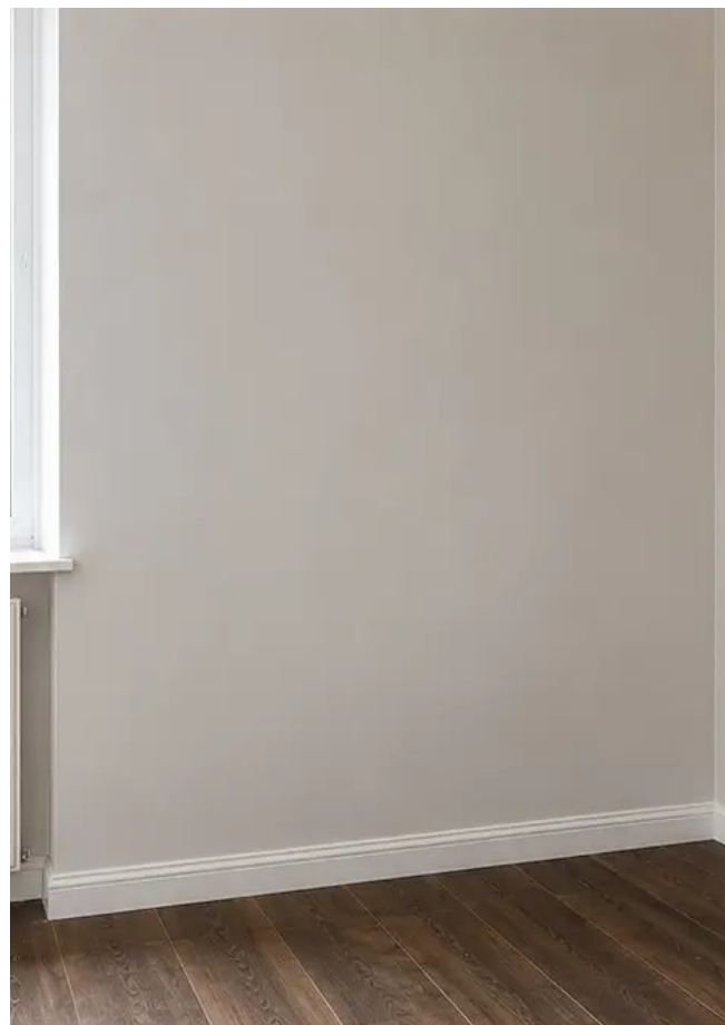
Fotografie č. 4 Stav zdi po opravě
