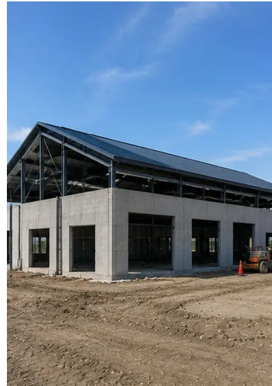
Fotografie č. 10. Výstavba střechy dokončena
