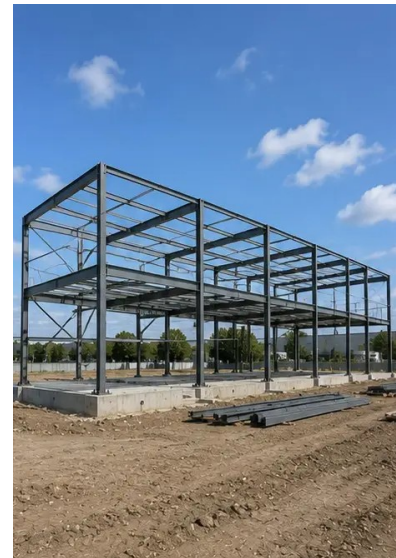
Fotografie č. 7. Výstavba konstrukčního skeletu probíhá
