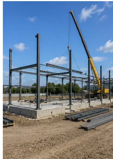
Fotografie č. 6. Zahájena montáž konstrukčního skeletu
