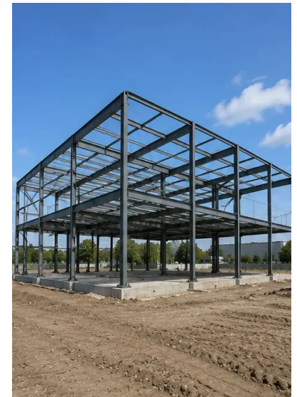
Fotografie č. 8. Konstrukční skelet dokončen dle harmonogramu projektu
