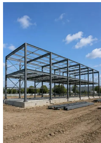
Fotografie č. 7. Výstavba konstrukčního skeletu probíhá
