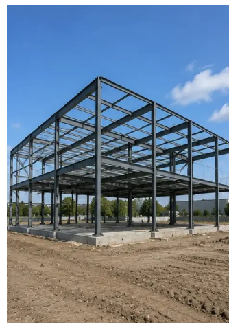
Fotografie č. 8. Konstrukční skelet dokončen dle harmonogramu projektu
