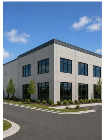
Fotografie č. 16. Dokončený projekt připraven k provozu
