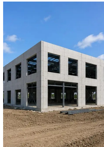
Fotografie č. 9. Konstrukční skelet dokončen dle harmonogramu projektu
