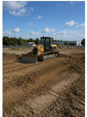
Fotografie č. 2. Probíhají přípravné práce na staveništi
