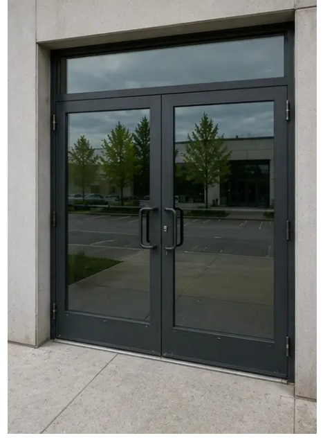
Photo #7. দরজার অবস্থা পরিদর্শন ও রেকর্ডকৃত
