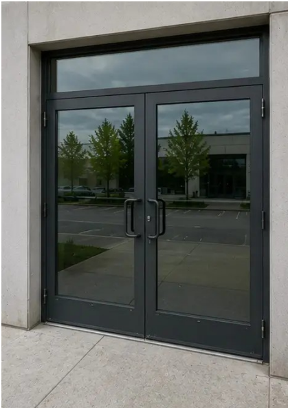
Photo #7. দরজার অবস্থা পরিদর্শন ও রেকর্ডকৃত
