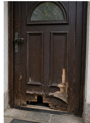
Photo #8. পরিদর্শনের সময় রেকর্ডকৃত ক্ষতিগ্রস্ত প্রবেশ দরজা
