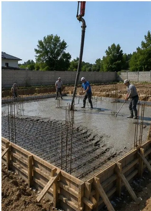
Снимка №5 Операция по бетониране, извършена върху фундаментни елементи
