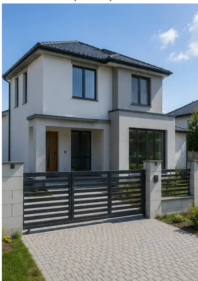
Снимка №15 Завършен екстериор на сградата след строителство
