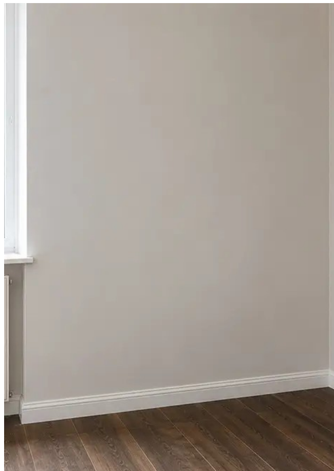
Снимка №4 Състояние на стената след ремонтни дейности
