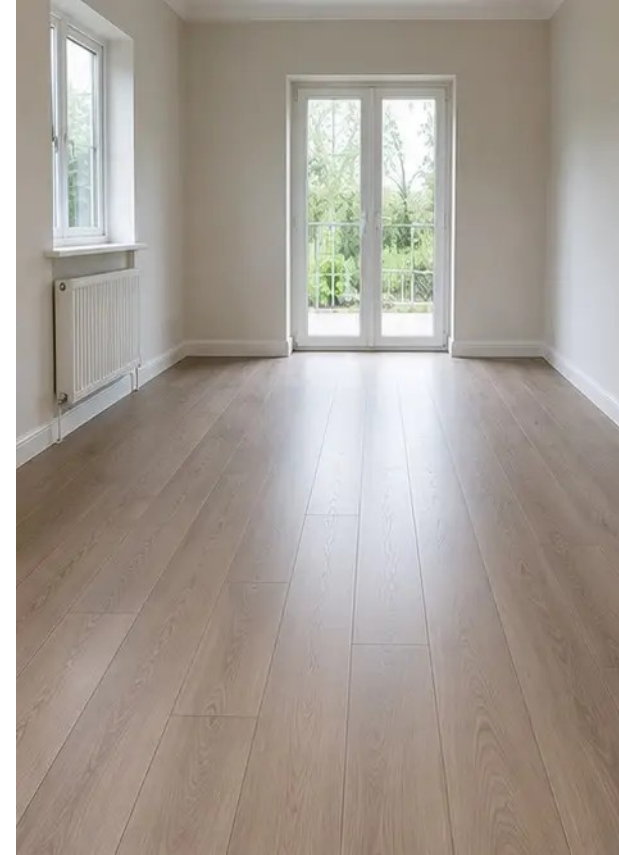
Снимка №6 Състояние на подовата настилка след подмяна
