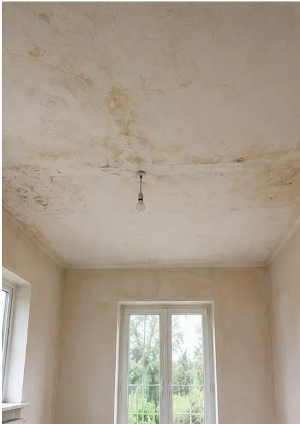
Снимка №7 Състояние на тавана преди ремонт
