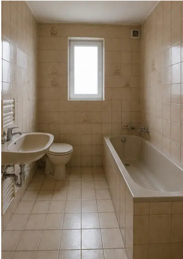
Снимка №9 Състояние на банята преди ремонт
