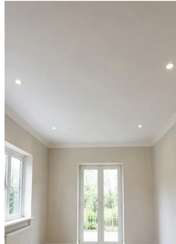
Снимка №8 Състояние на тавана след ремонт
