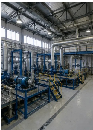
Снимка №1. Общ преглед на промишленото съоръжение
