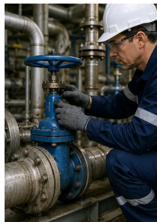
Снимка №10. Състояние на арматурата, оценено при инспекцията
