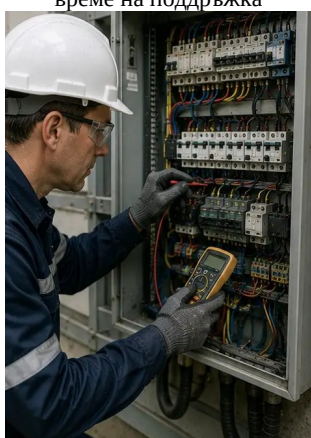
Снимка №5. Извършена инспекция на електрически шкаф
