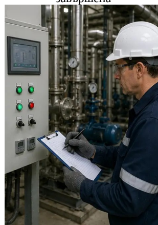
Снимка №14. Извършена окончателна проверка на поддръжката
