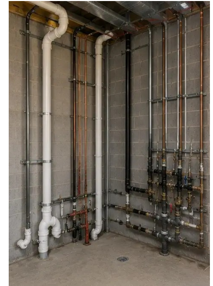
Снимка №12. Монтаж на водопроводни системи завършен
