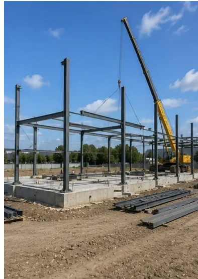
Снимка №6. Започнато сглобяване на конструктивната рамка
