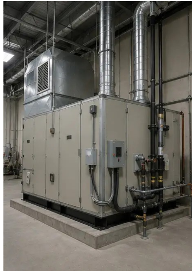
Снимка №14. Монтаж на оборудване завършен
