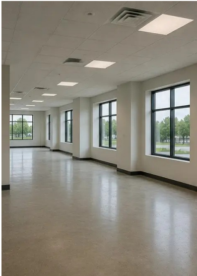
Снимка №13. Вътрешни довършителни работи в ход
