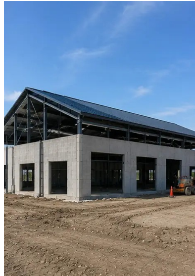
Снимка №10. Изграждане на покрива завършено
