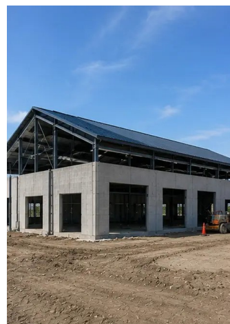
Снимка №10. Изграждане на покрива завършено
