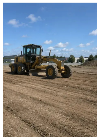
Снимка №3. Почистване и изравняване на терена завършено
