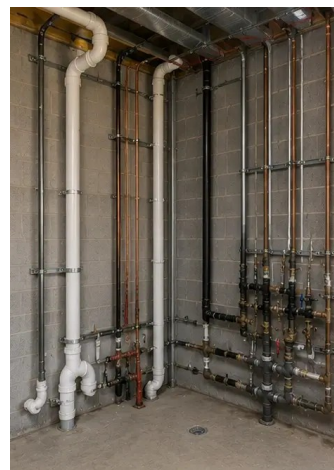
Снимка №12. Монтаж на водопроводни системи завършен
