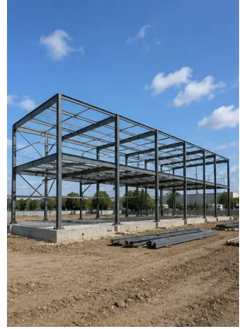
صورة رقم 7. بناء الهيكل الإنشائي قيد التنفيذ
