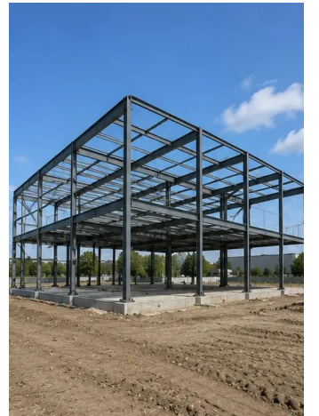
صورة رقم 8. الهيكل الإنشائي مكتمل وفقًا للجدول الزمني للمشروع
