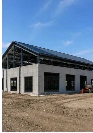
صورة رقم 10. بناء السقف مكتمل
