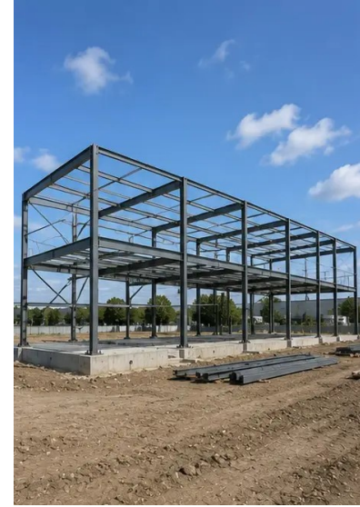
صورة رقم 7. بناء الهيكل الإنشائي قيد التنفيذ
