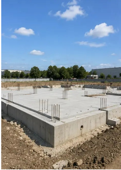
صورة رقم 5. بناء الأساسات مكتمل
