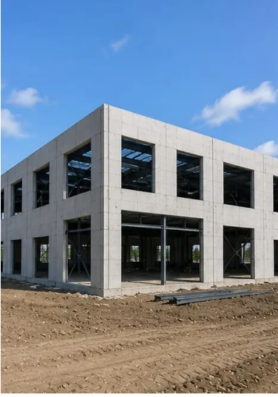
صورة رقم 9. Structural frame completed according to project schedule
