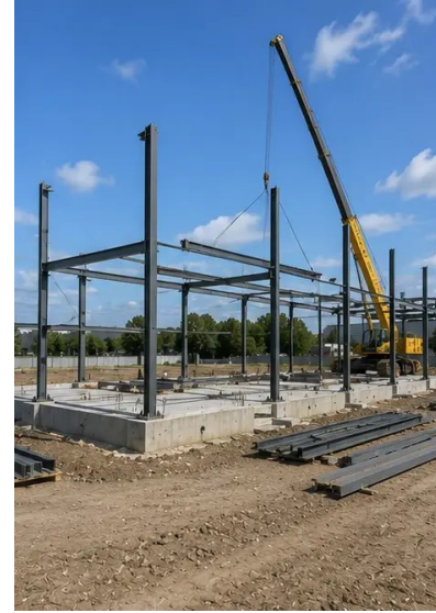
صورة رقم 6. بدأ تجميع الهيكل الإنشائي
