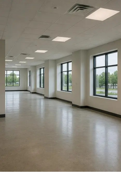
صورة رقم 13. أعمال التشطيب الداخلي قيد التنفيذ
