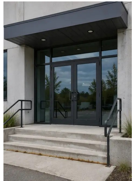
منطقة المدخل الرئيسي التي تم فحصها وتوثيقها. Photo #3.
