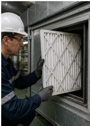
صورة رقم 7. استبدال فلتر الهواء مكتمل
