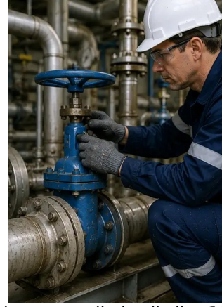
صورة رقم 10. حالة الصمام التي تم تقييمها أثناء الفحص
