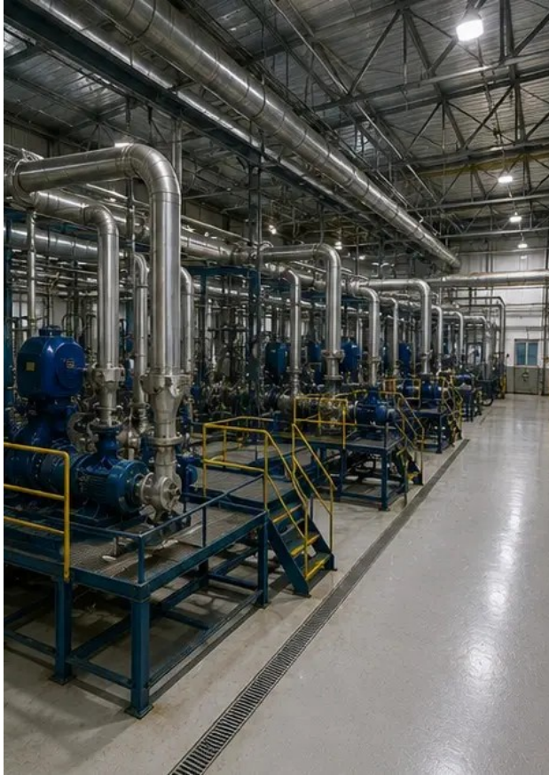
صورة رقم 16. نظرة عامة على المنشأة بعد اكتمال أعمال الصيانة
