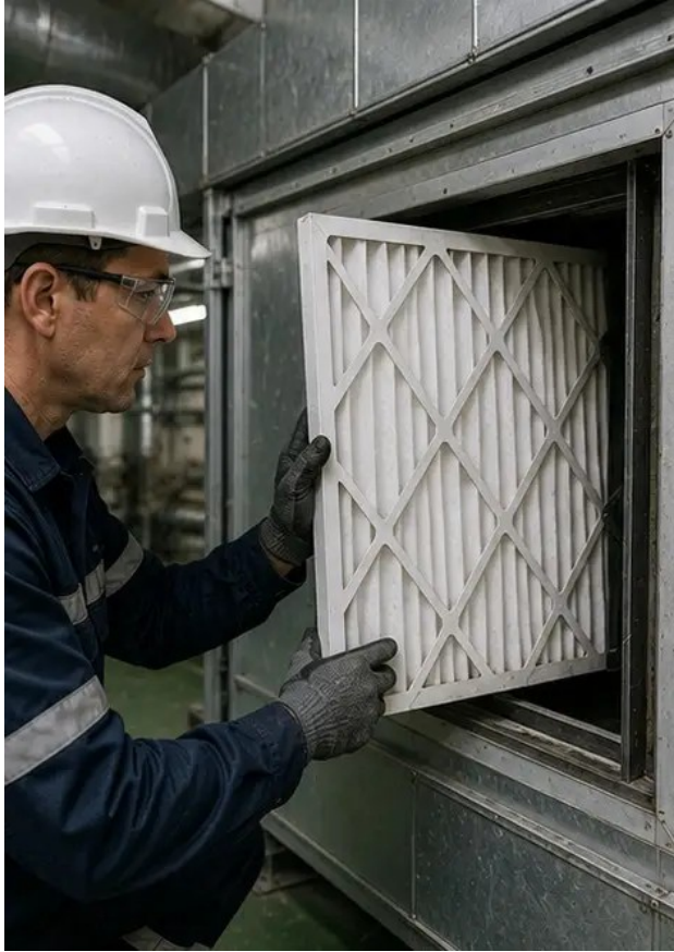
صورة رقم 7. استبدال فلتر الهواء مكتمل
