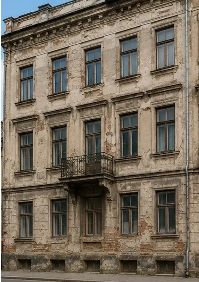
صورة رقم 13 واجهة المبنى قبل أعمال الترميم
