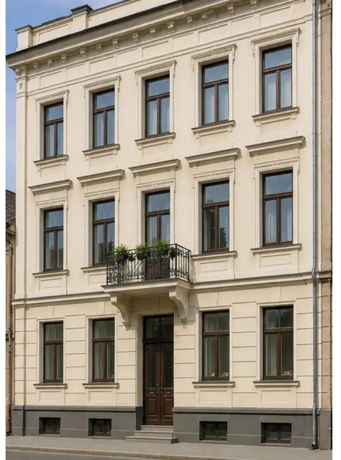
صورة رقم 14 واجهة المبنى بعد أعمال الترميم
