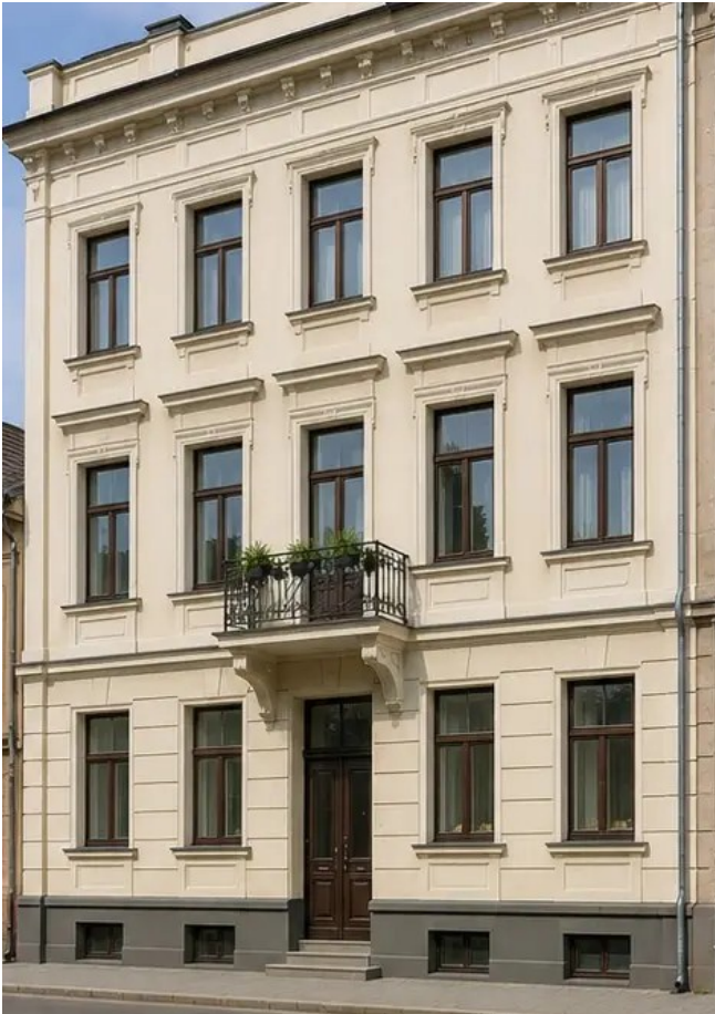
صورة رقم 14 واجهة المبنى بعد أعمال الترميم
