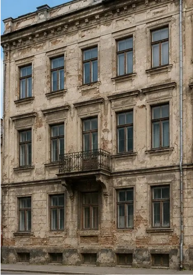
صورة رقم 13 واجهة المبنى قبل أعمال الترميم
