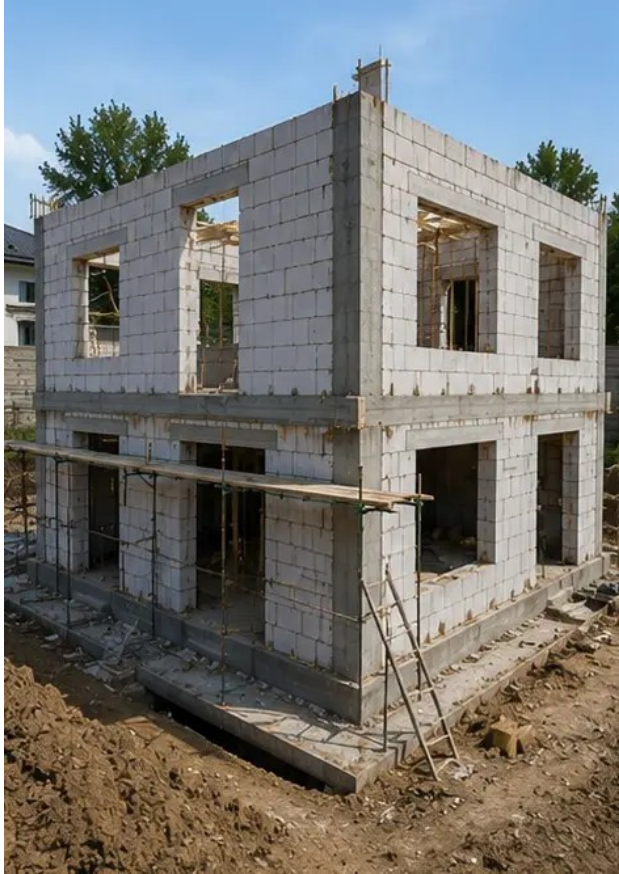
صورة رقم 7 بناء الجدران الخارجية مكتمل لقسم المبنى
