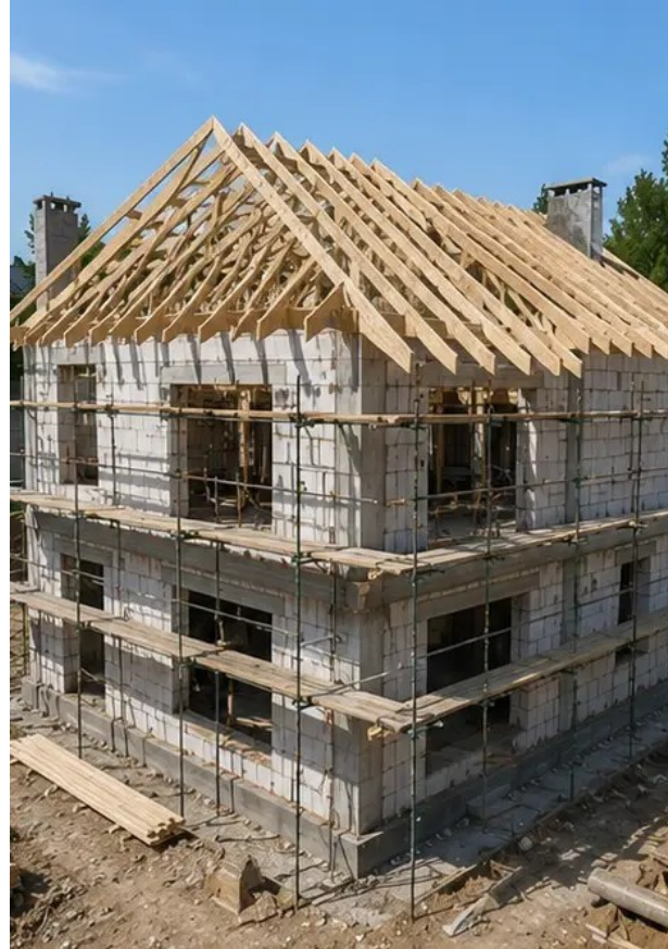
صورة رقم 8 أعمال تركيب السقف مكتملة
