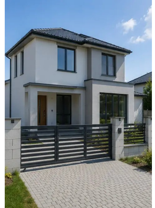
صورة رقم 15 المظهر الخارجي للمبنى بعد اكتمال البناء
