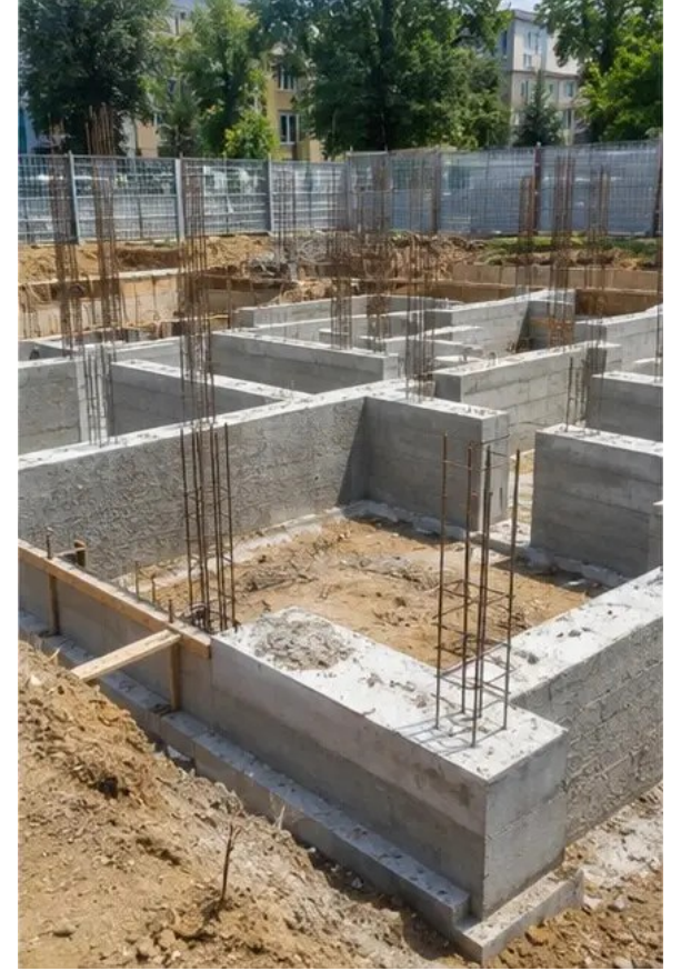
صورة رقم 3 بناء الأساسات قيد التنفيذ
