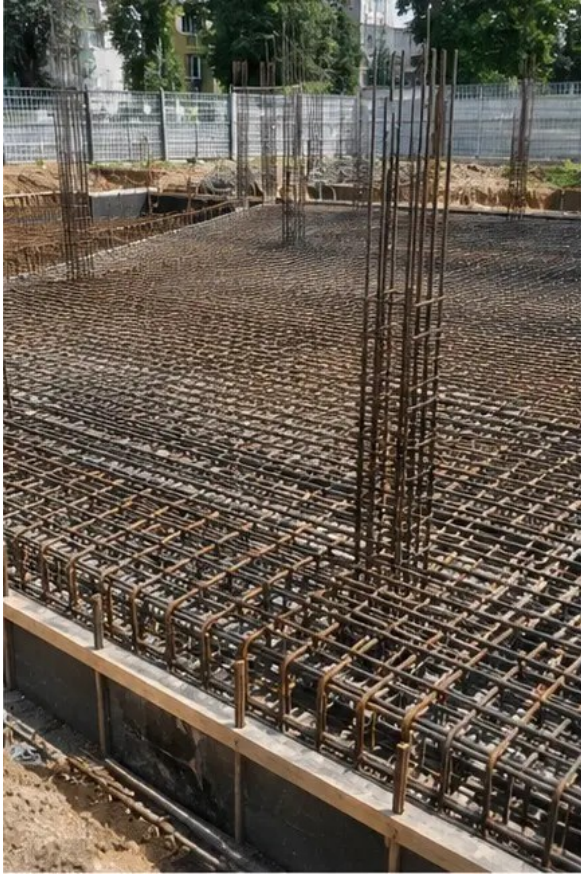
صورة رقم 4 تركيب حديد التسليح مكتمل قبل صب الخرسانة
