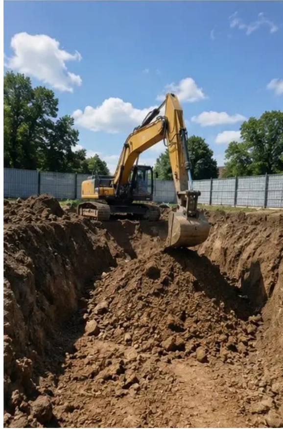
صورة رقم 2 أعمال الحفر المنفذة وفقًا لمتطلبات المشروع
