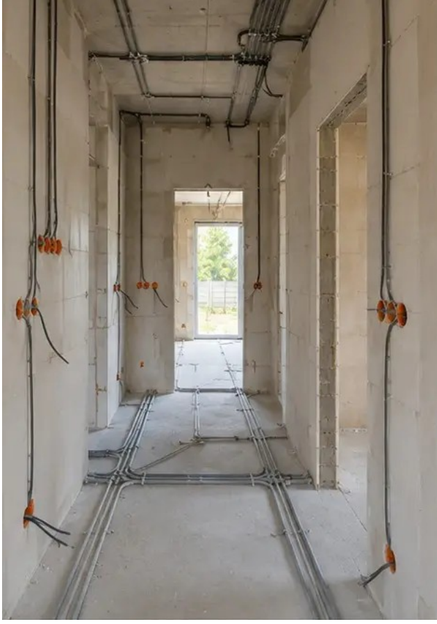
صورة رقم 9 تركيب الأنظمة الكهربائية قيد التنفيذ
