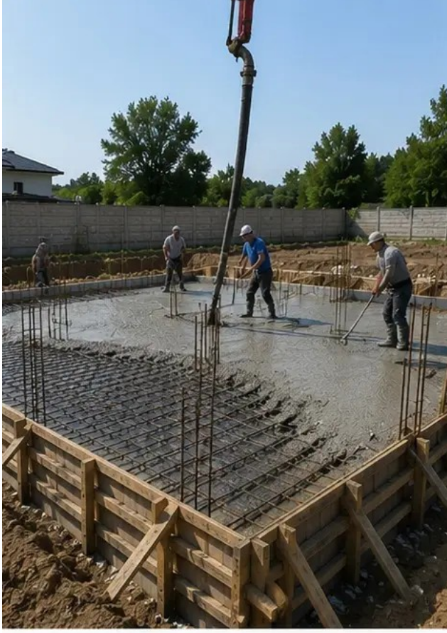
صورة رقم 5 عملية صب الخرسانة المنفذة على عناصر الأساسات
