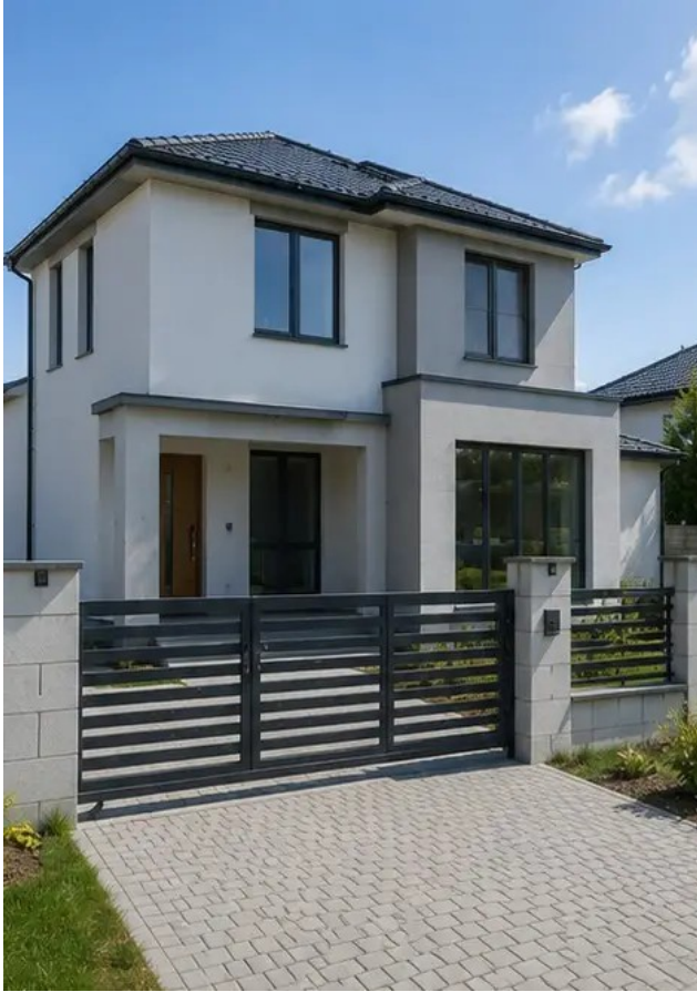
صورة رقم 15 المظهر الخارجي للمبنى بعد اكتمال البناء
