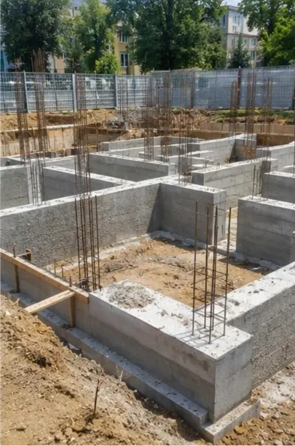
صورة رقم 3 بناء الأساسات قيد التنفيذ
