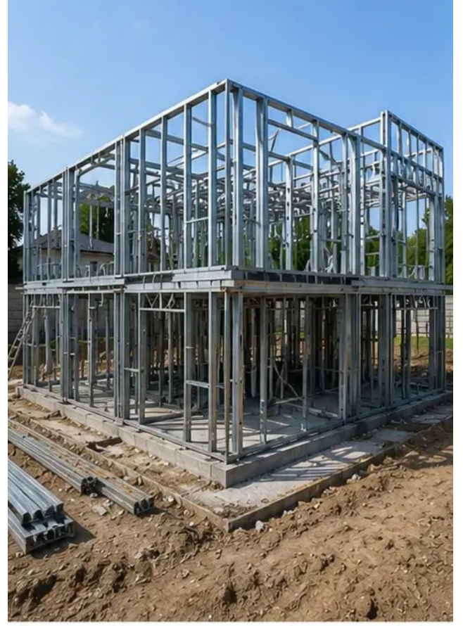
صورة رقم 6 تجميع الهيكل الإنشائي قيد التنفيذ
