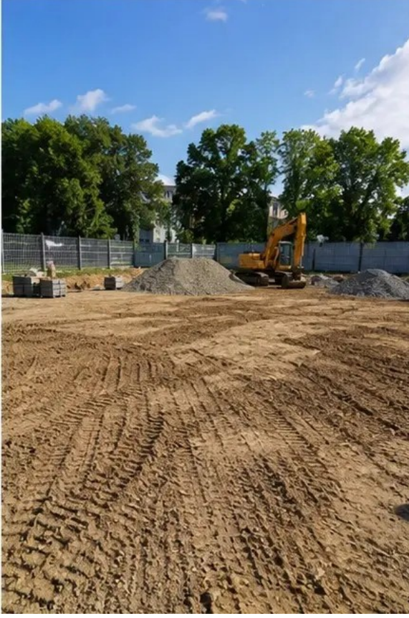
صورة رقم 1 أعمال تجهيز الموقع المنجزة قبل بدء البناء
