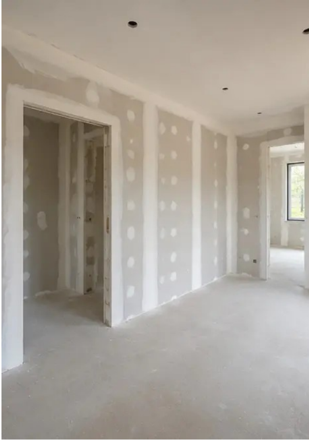
صورة رقم 11 أعمال تشطيب الجدران الداخلية قيد التنفيذ
