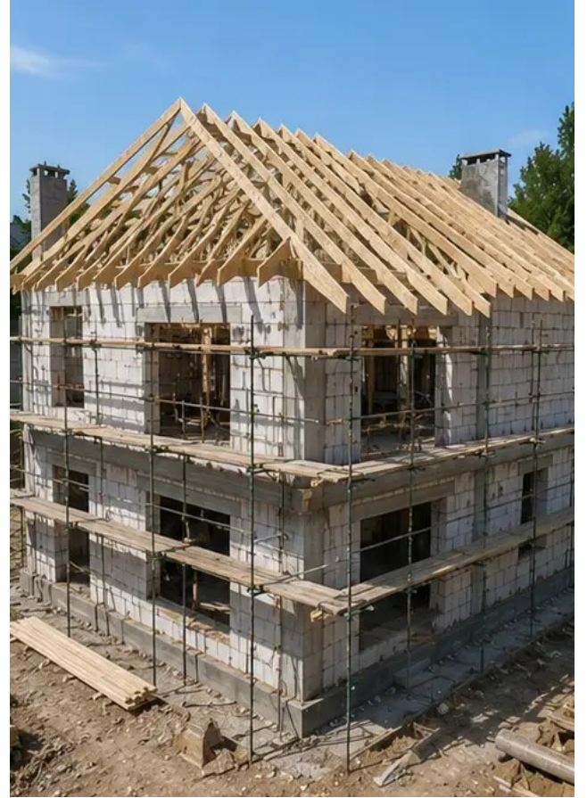
صورة رقم 8 أعمال تركيب السقف مكتملة
