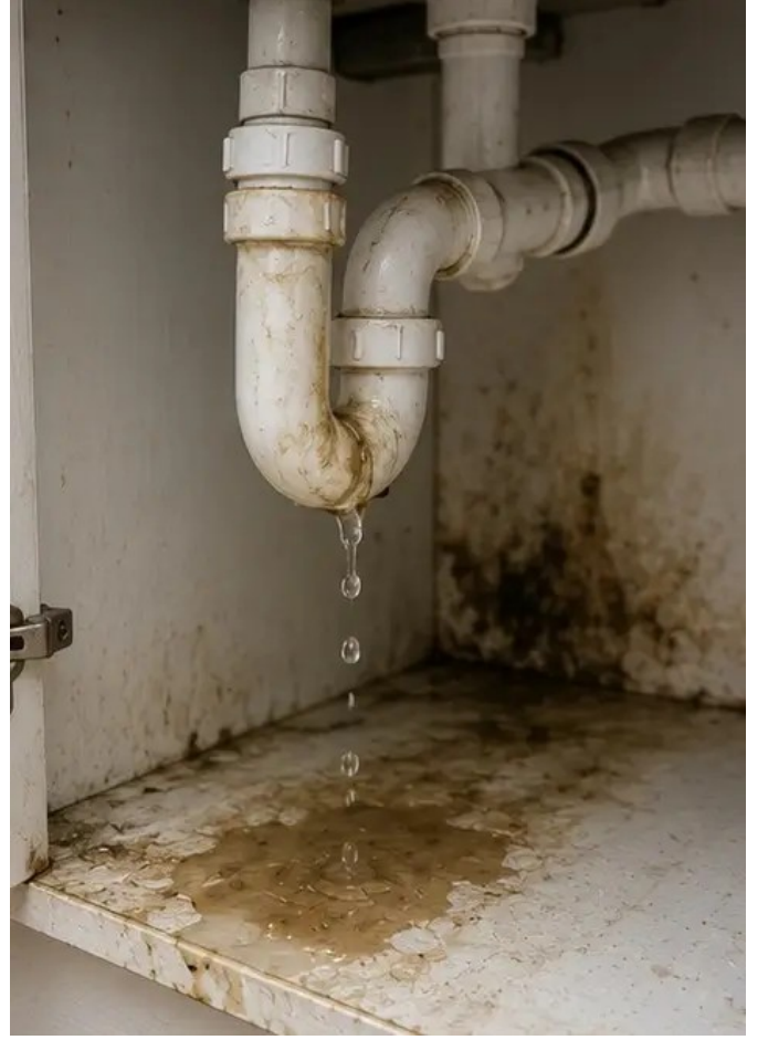
صورة رقم 11 أضرار تسرب السباكة الموثقة
