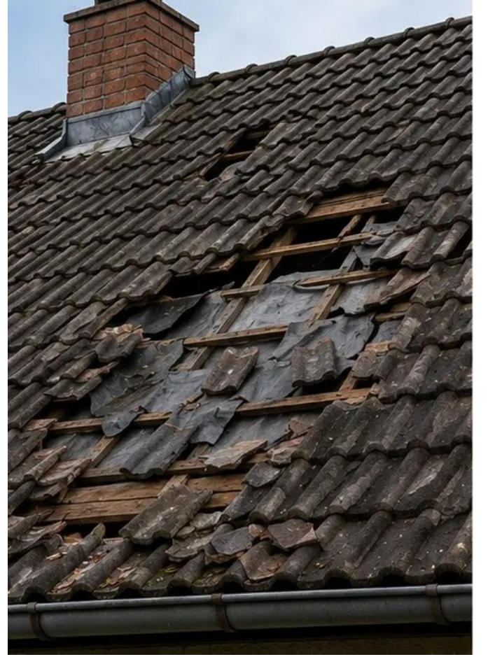
صورة رقم 3 منطقة السقف المتضررة المحددة والمسجلة
