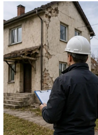
Photo #16. الصورة الختامية لمخلص فحص الأضرار
