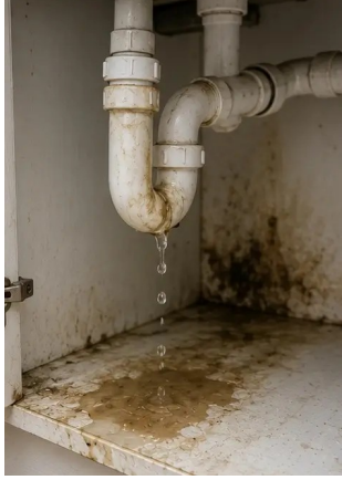
Photo #11. أضرار تسرب السباكة الموثقة
