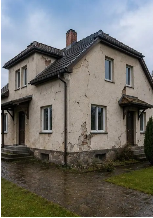
صورة رقم 1 منظر عام للعقار الذي تم فحصه
