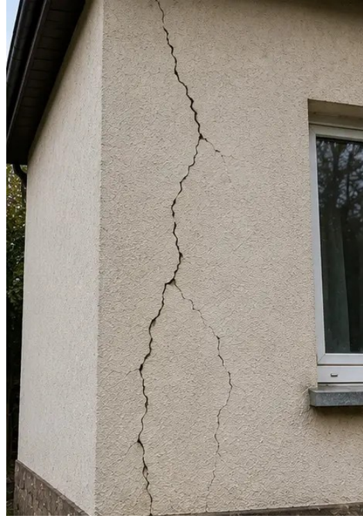
صورة رقم 5 شخ الجدار الإنشائي الموثق أثناء الفحص
